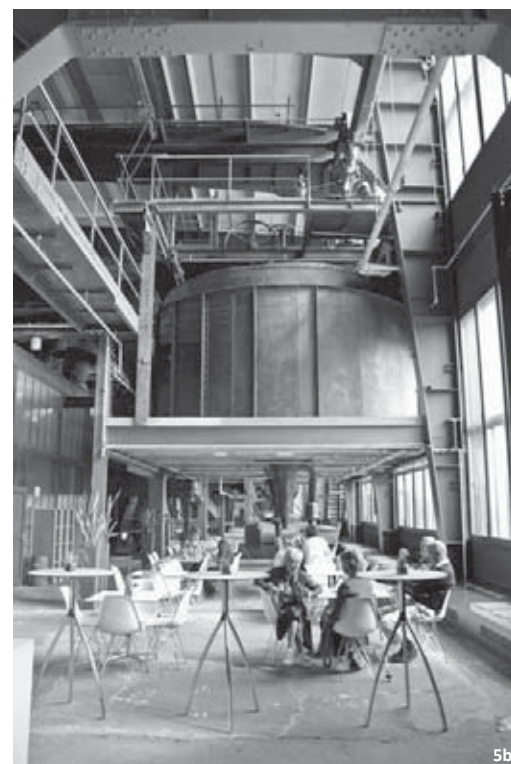
Sl. 5a, 5b: Obstoječo fasado pralnice premoga v Zeche Zollverein XII so zamenjali zaradi nove muzejske vloge objekta. To je izzvalo številne polemike in izpostavilo vprašanje primernosti tako intenzivnega poseganja v spomenik svetovne dediščine. Proizvodna oprema v gornjih etažah objekta je ostala popolnoma ohranjena in tako ključno dopolnjuje predstavitev njegove prvotne vloge. Foto: P. Šušteršič, J. Lah.
