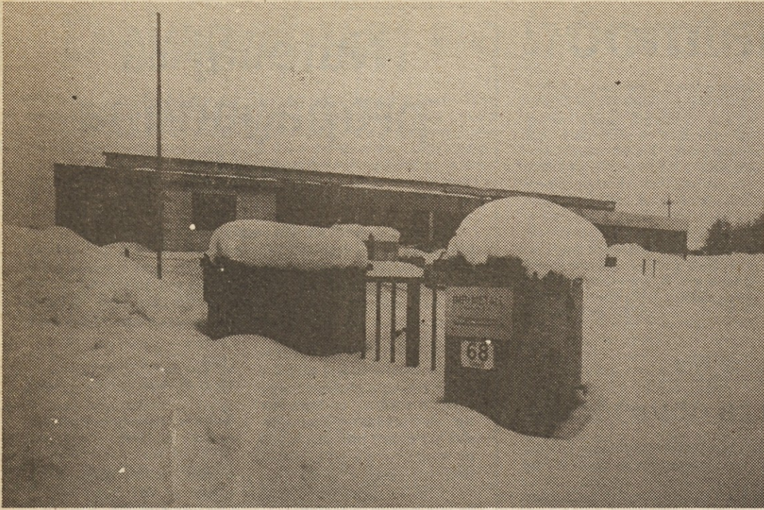
Stavba IMP Metalla. Na desni pogled v notranjost novega prizidka.
