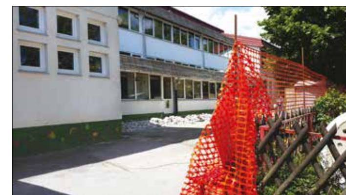
Šola - začetek energetske sanacije
