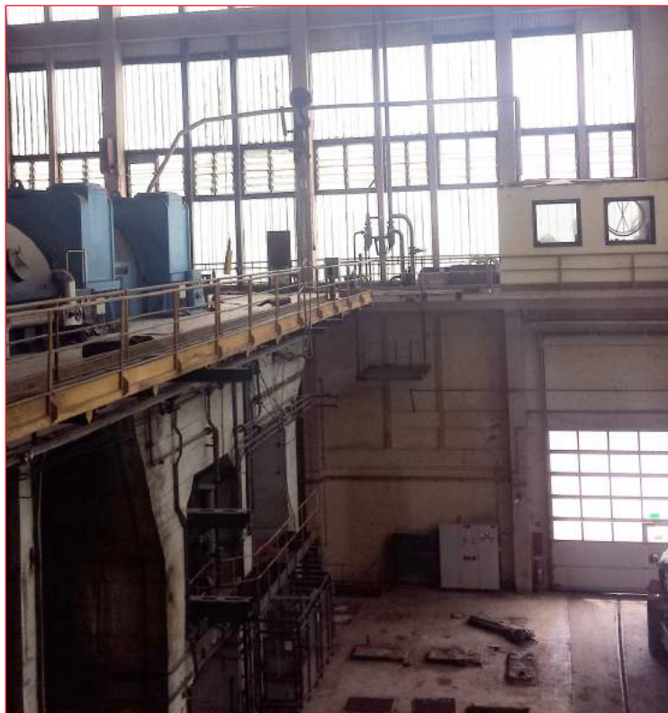
Slika 23: Notranji prostori opuščene hale Termoelektrarne Trbovlje (V. Gajić, 2018).
