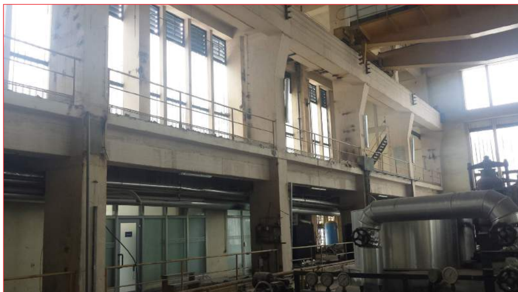
Slika 25: Notranji prostori opuščene hale Termoelektrarne Trbovlje (V. Gajić, 2018).
