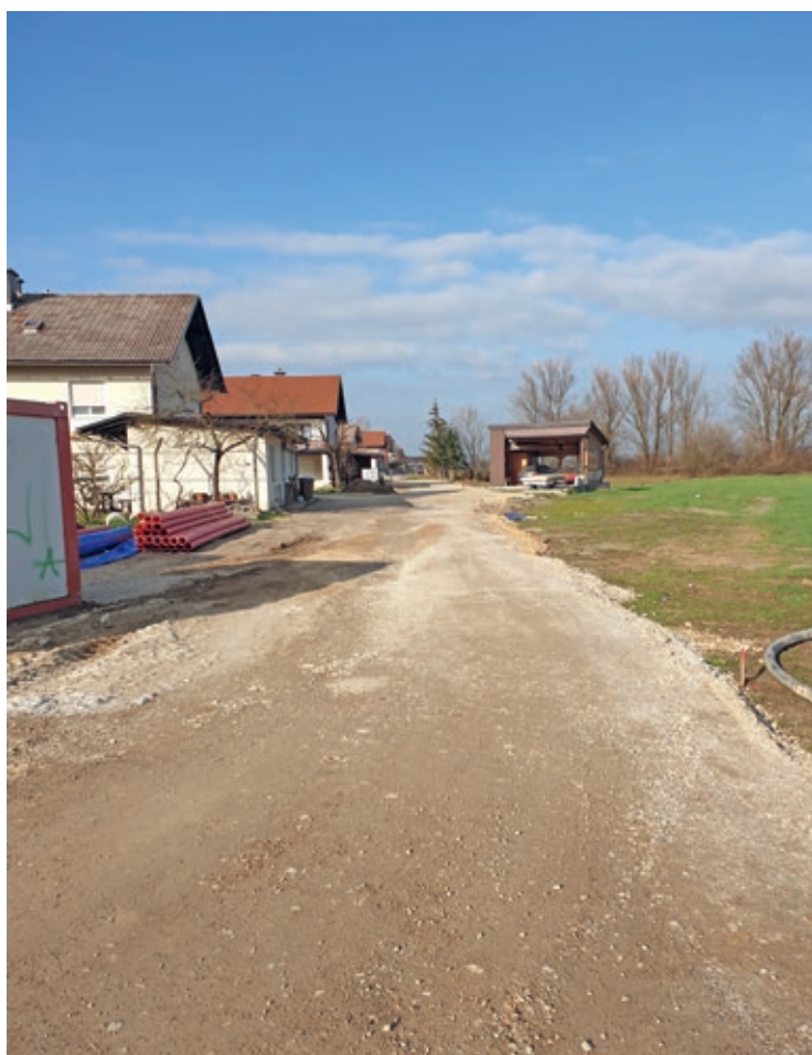
V zadnji ulici na Barjanski ulici se je po izgradnji in prestavitvi kanalizacije izvedla še obnova vodovodnega omrežja in priključkov.
