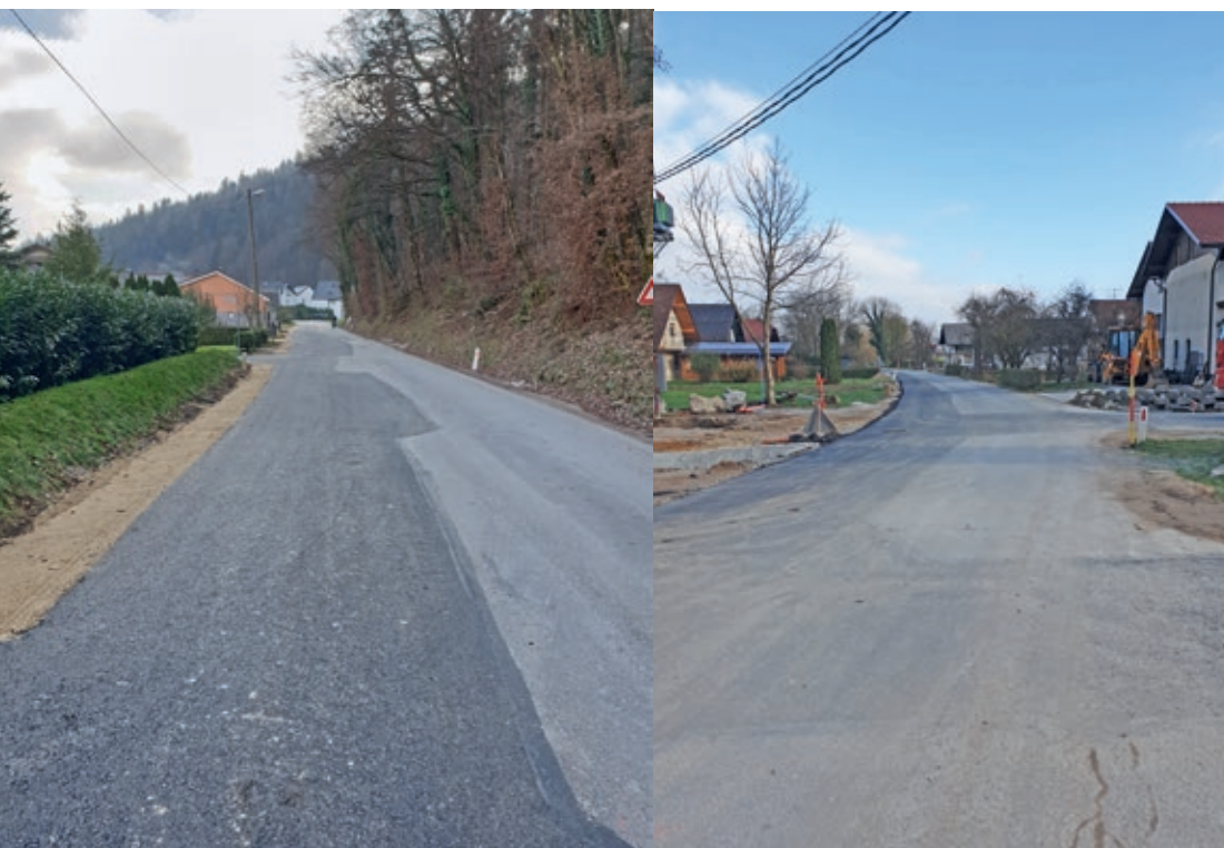
V Tomišlju so bila do konca novembra izvedena vsa dela na vodovodu in kanalizaciji. V decembru se bo izvajal le še elektro priključek za črpališče in priključitev črpališča.
