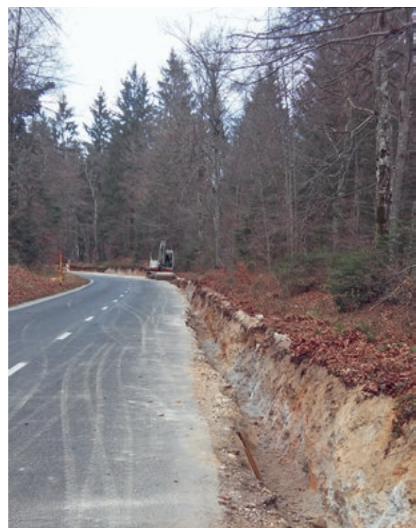
Konec novembra so se začela dela pri obnovi vodovoda od VH Kurešček do jaška.
