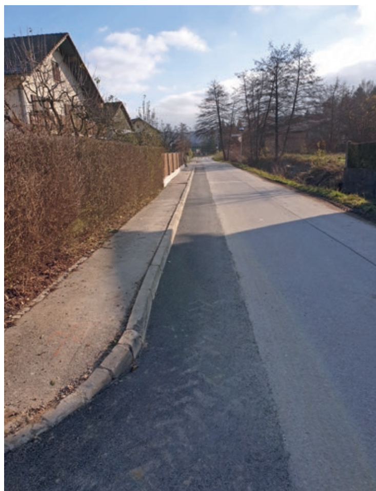
Na Kalinovi in Ponirkovi ulici je bila izvedena obnova vodovodnega omrežja in priključkov. Prav tako se je saniralo javno vodovodno omrežje od Škurhove do Kalinove ulice ob potoku in izvedle so se prevezave v vse ulice.
