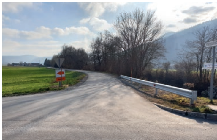
Novi vzdrževalec občinskih cest je na cesti proti pokopališču Tomišelj postavil novo odbojno varnostno ograjo.
