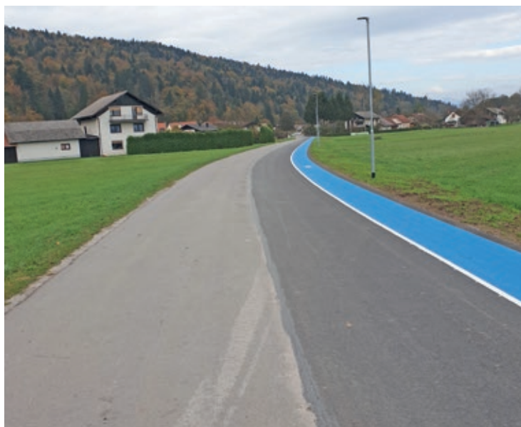
Zgrajen nivojski hodnik za pešce v Tomišlju od vasi proti kapelici
