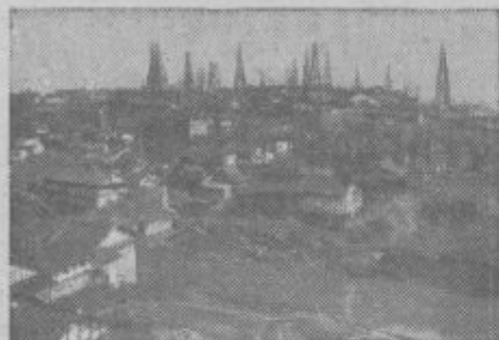
Primitivni vrtalni stroji, ki dosega- jo višino 30 do 40 m
