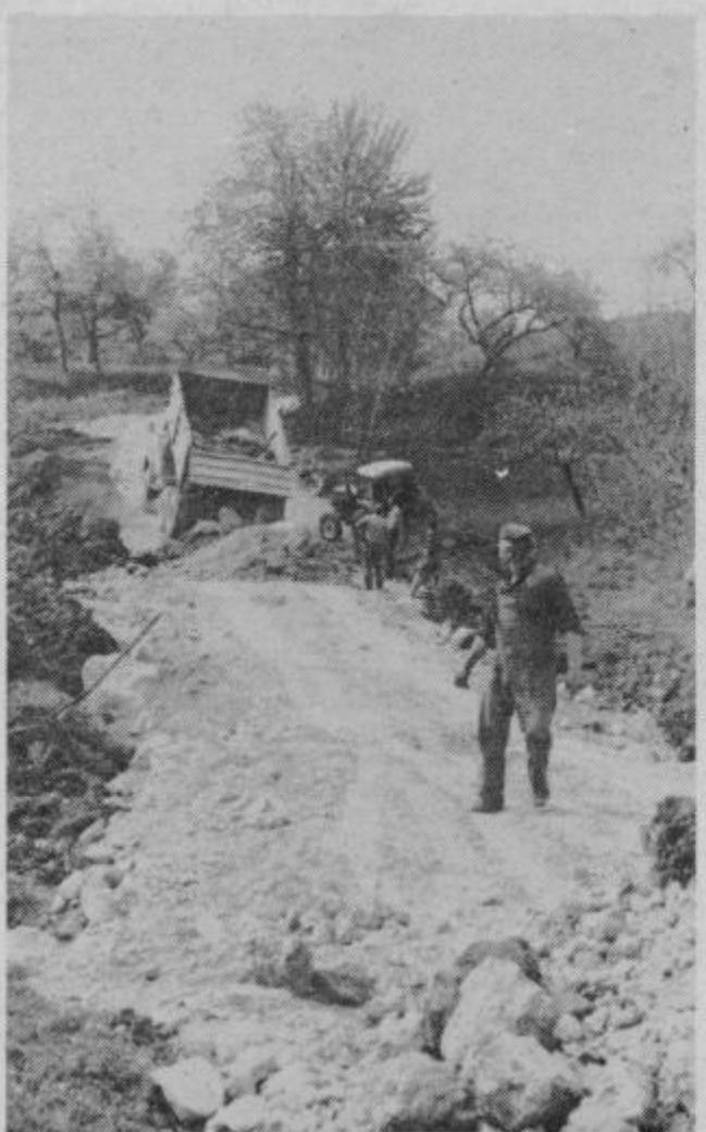
Vaščani Dorega polja so morali zaradi plazu prestaviti cesto. Delo ki je trajalo šest tednov, je že skoraj končano, zato se na sliki ne vidi, koliko truda so morali vložiti v sanacijo. Doslej so zabili kar 96 pilotov, za postavitev enega mora šest ljudi delati več kot eno uro. Ta cesta je verjetno tudi edina v šentjurski občini, ki stoji na pilotih.
