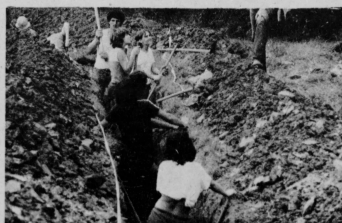
Izkop jarka za vodovod v KS Benedikt, občina Lenart.
