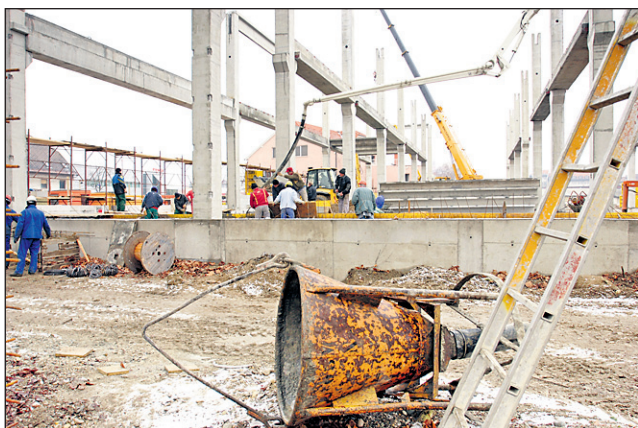
Glavni izvajalec del je bil Vegrad v sodelovanju s Konstruktorjem, kot podizvajalci pa so delali številna ptujska podjetja in obrtniki.
