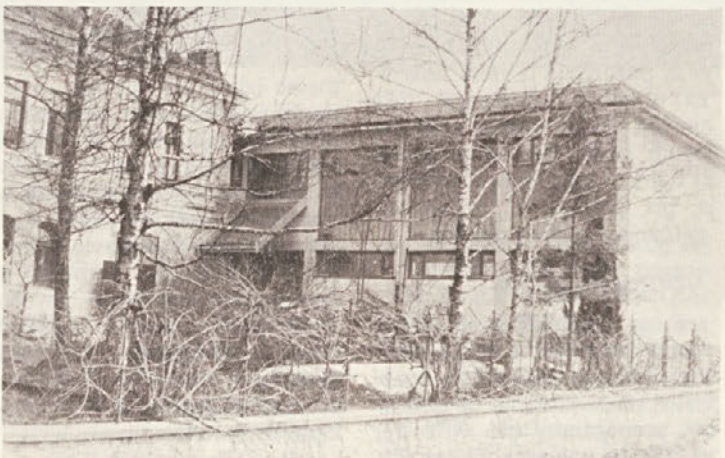
Nova telovadnica osnovne šole v Kostanjevici je prizidek ob starem šolskem poslopju.
