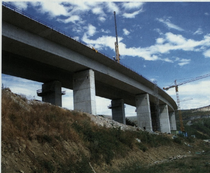
Slika 10 • Pogled na zgrajen pobočni del viadukta z ločenimi stebri, september 2003
