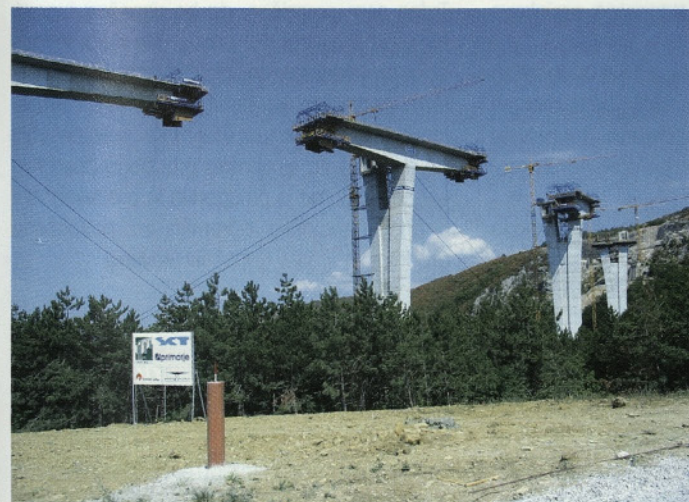
Slika 14 • Pogled na visoke stebre in konzolne mize med gradnjo prekladne konstrukcije
