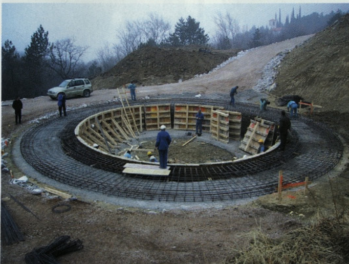
Slika 12 • Izvedba betonskega prstana ter izkop vodnjaka podpore 5
