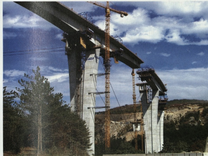
Slika 7 • Pogled na viadukt med gradnjo, oktober 2003
