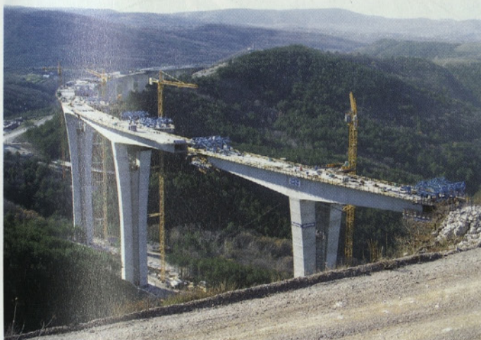
Slika 5 • Pogled na viadukt Črni Kal med gradnjo s ceste Ljubljana-Koper
