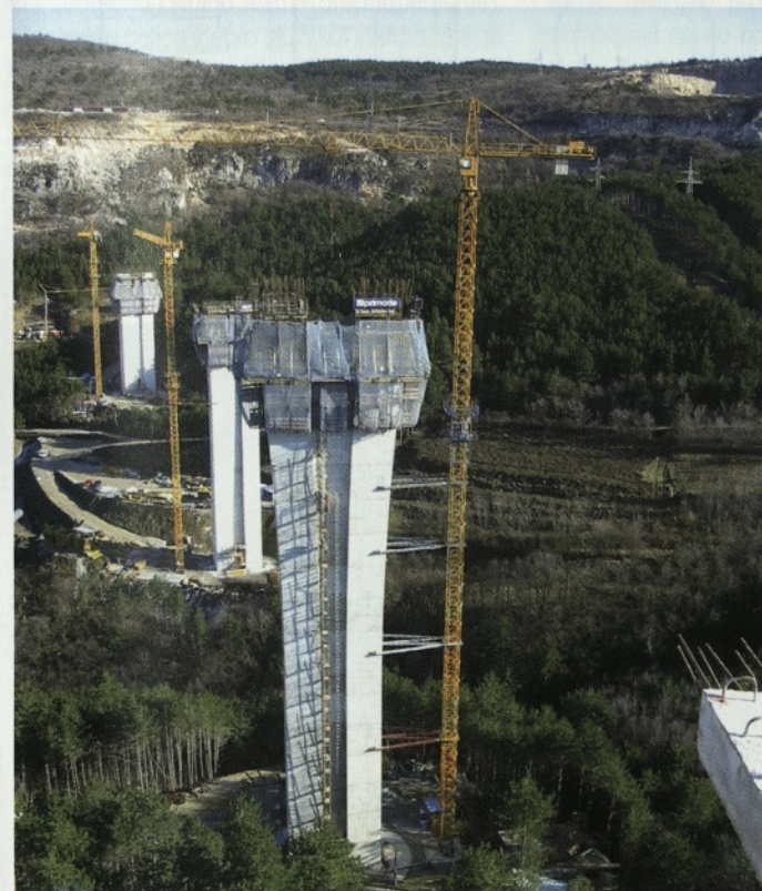
Slika 9 • Pogled na samoplezajoči opaž in steber podpore 5 v fazi gradnje
