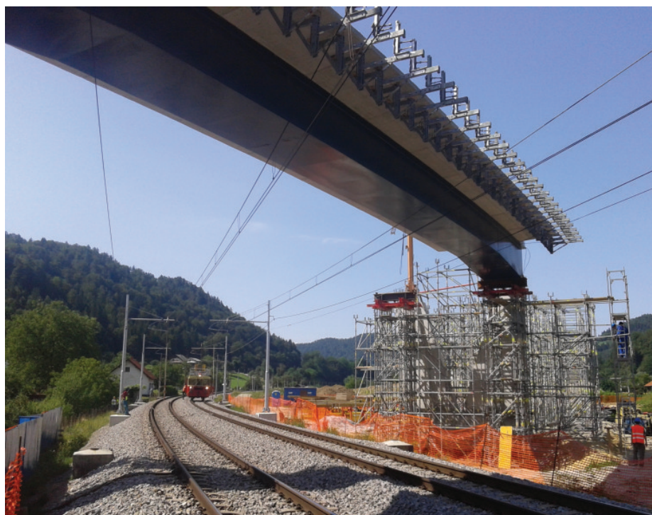
Slika 9 • Začasne podpore, postavljene ob stebrih nadvoza, na obeh straneh železniške proge
