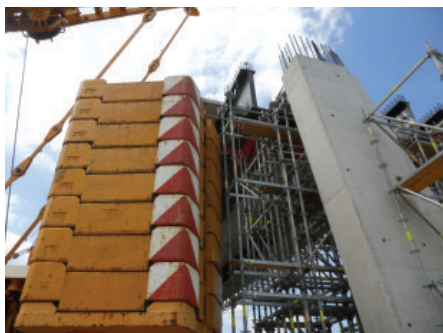
Slika 12 • Protiutež avtodvigala ob začasni podporni konstrukciji
