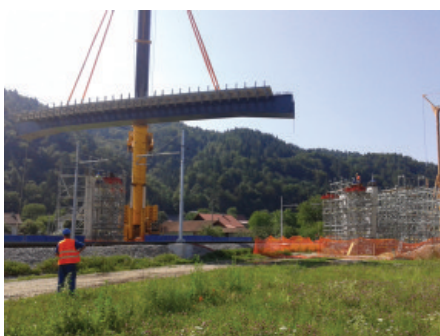
Slika 13 • Montaža nosilca na začasno podporno konstrukcijo
