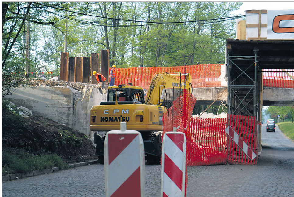
Pogled na železniški nadvoz nad Tovarniško cesto v Kidričevem, kjer so del zgornje plošče že porušili, promet po Tovarniški cesti pa poteka enosmerno.
