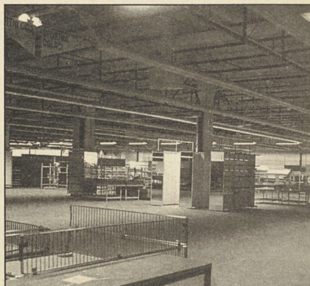
Oprema se že montira.
