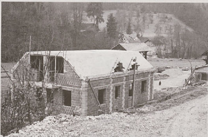
V začetku decembra hiša že čaka na streho
