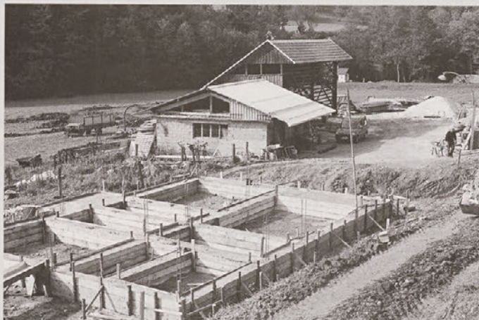
Začetek gradnje - temelji
