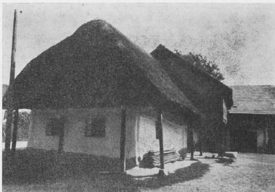
Sl. 2. Stari tip kmečkega doma v Sebeborcih. Dom je »v ključu«. Hiša je zgrajena iz ilovice, lesa in krita s slamo. V zadnjih letih ta tip hiše zamenjuje zidana in večja hiša.
