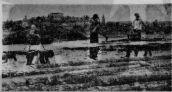
Dela pri graditvi perutinarskefarme še vedno v polnem teku.
