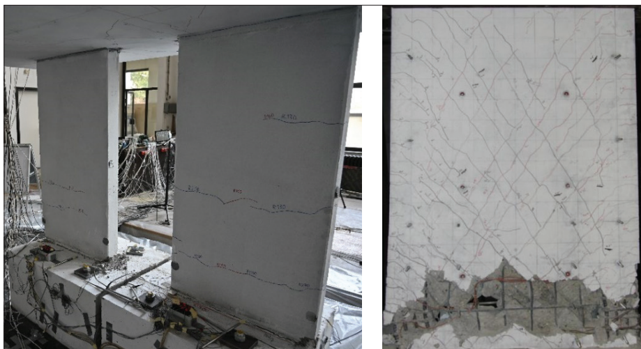
Slika 8 • Razpoke v stenah testirane konstrukcije (levo), razpoke, ki so značilne za konzolne stene (desno).
