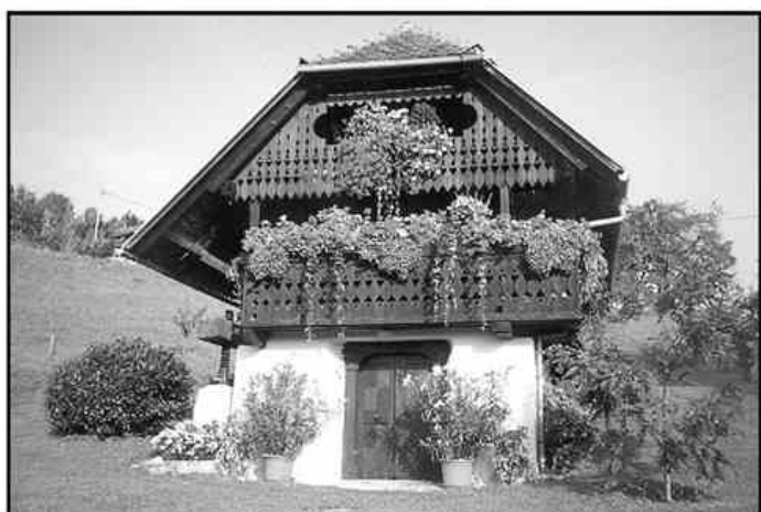
Obnova stanovanjske hiše z letnico 1810 je bila najtežji zalogaj.
