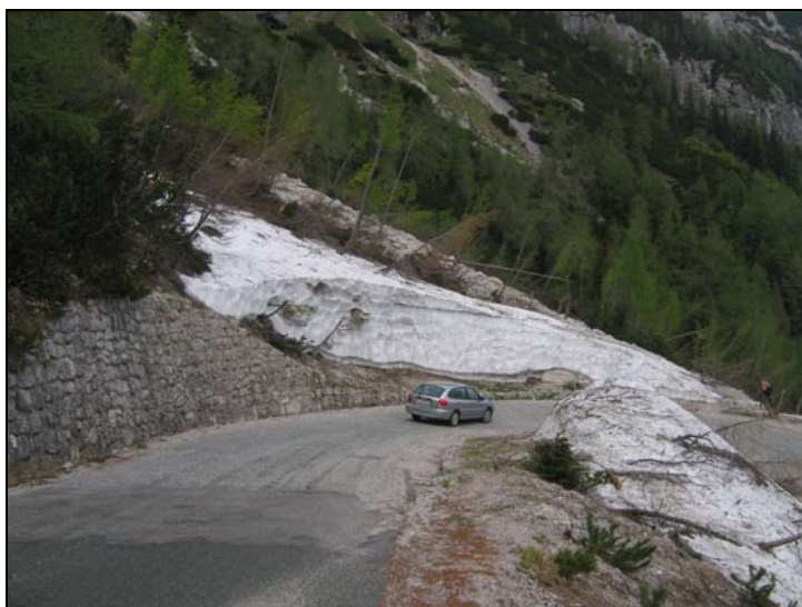
Slika 5: Največje težave na vršiški cesti povzročajo snežni plazovi, ki se prožijo nad 24. oziroma zadnjo serpentino na gorenjski strani ceste. To potrjuje plazovina na obeh straneh ceste ob koncu pomladi, ki skopni po povprečno snežni zimi šele na začetku poletja (fotografija: Miha Pavšek).
