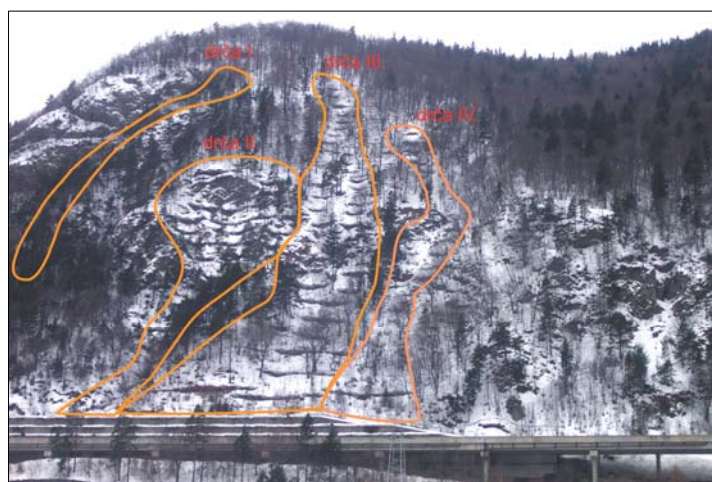
Slika 5: Pobočje Mežakle nad avtocesto Hrušica–Vrba decembra 2005 z označenimi območji na katerih so varovalni objekti – sistemi varovanja s snežnimi mrežami preprečujejo proženje snežnih plazov.
