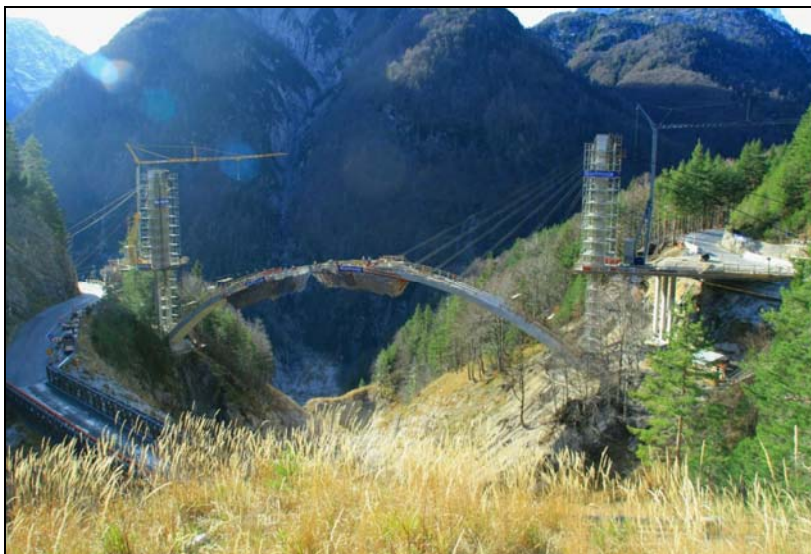
Slika 6: Največji ločni most v Triglavskem narodnem parku nad dolino Mangartskega potoka bo ohranil 'družbeni spomin' na naravni proces iz leta 2000 tudi potem, ko bo 'naravni spomin' v obliki učinkov erozije na pobočjih in novega nanosa drobirja v dolinskem dnu že nekoliko zabrisan z obnovljenim rastjem (fotografija: Romeo Černuta).
