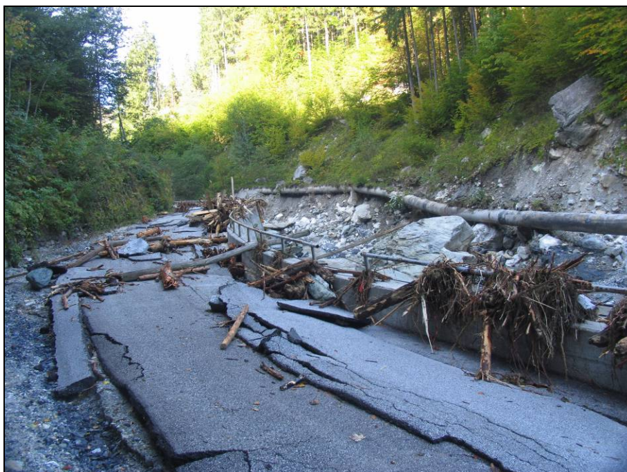
Slika 5: Hudourniške poplave so lahko zelo uničujoče – primer ceste ob Davči po ujmi 18. septembra 2007.
