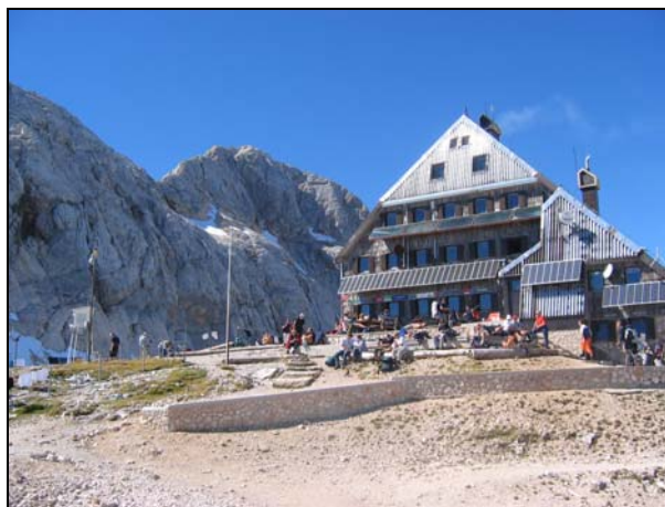
Slika 7: Triglavski dom na Kredarici. Zgradba je obložena s trapezno pločevino. Čeprav veter v nižinah večkrat odkrije tovrstno kritino in se je zaradi tega začelja oprijemati slab sloves odpornosti proti vetru, primer potrjuje, da korektna izvedba lahko uspešno kljubuje tudi vetru preko 50 m/s (fotografija: Jernej Iskra).
