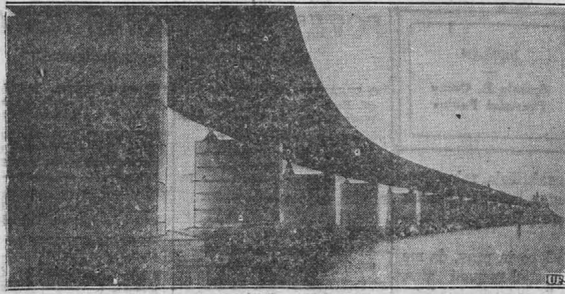
Na svoj rojstni dan, ki ga je nedavno obhajal, je danski kralj Kristijan otvoril novi most, ki veže otoka Zealand in Falster. Most je dolg 10.432 čevljev in je najdaljši v celi Evropi. Njega graditev je stala nekaj manj kot deset milijonov dolarjev.
