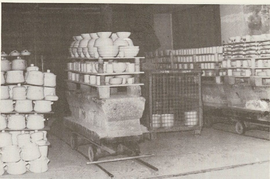
Prvo-biskvitno žganje v tunelski peči pri temperaturi 960°C.
