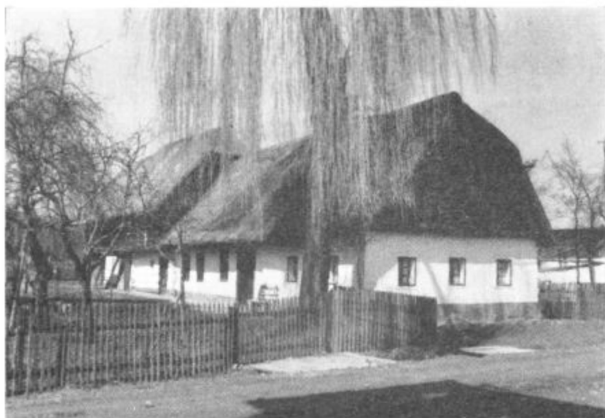
Hmeljarstvo in industrija sta prinesla v mnoga dolinska savinjska naselja fiziognomične spremembe. Toda v neposredni bližini najmočnejših industrijskih žarišč Sp. Savinjske doline — V Vrblju se je ohranil iz preteklega stoletja tipični kmečki dom savinjskega kmeta
