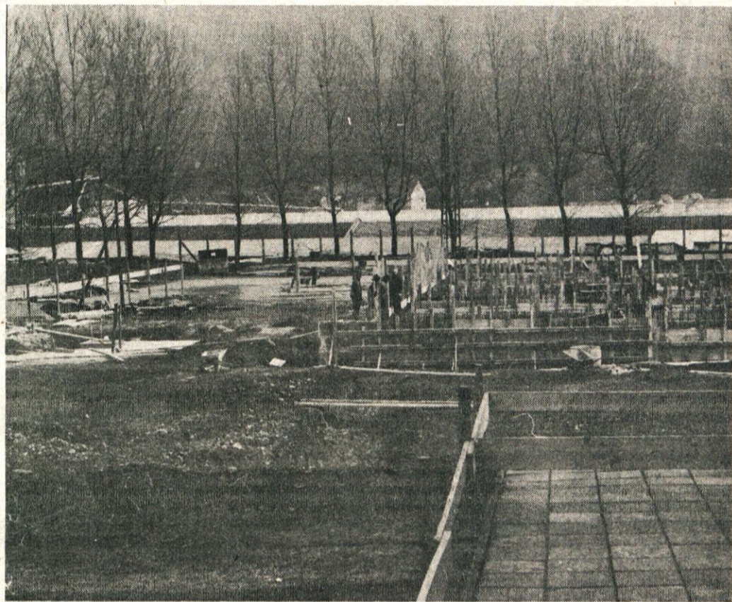
Gradnja prizidka k osnovni šoli Borovnica teče po predvidenem rokavem planu. Vsa nesoglasja okrog samega projekta so razjasnjena in delavci SGP Grosuplje — TOZD Igrad iz Vrhnice so že zgradili temelje.
