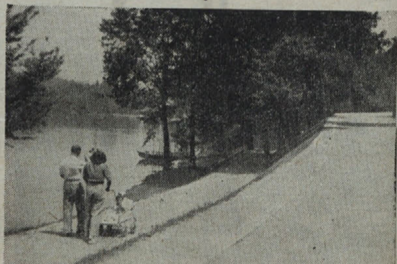
NOVA ASFALTIRANA CESTA BOKMALU TEKLA OKROG BLEJSKEGA JEZERA
