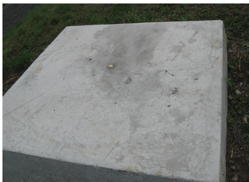
Slika 6: Talni reper, vgrajen v beton.
