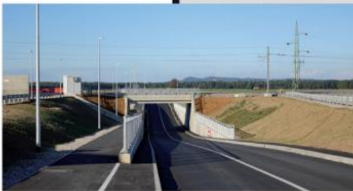
Eden od štirih novih podvozov, zgrajenih v občini Kidričevo.
