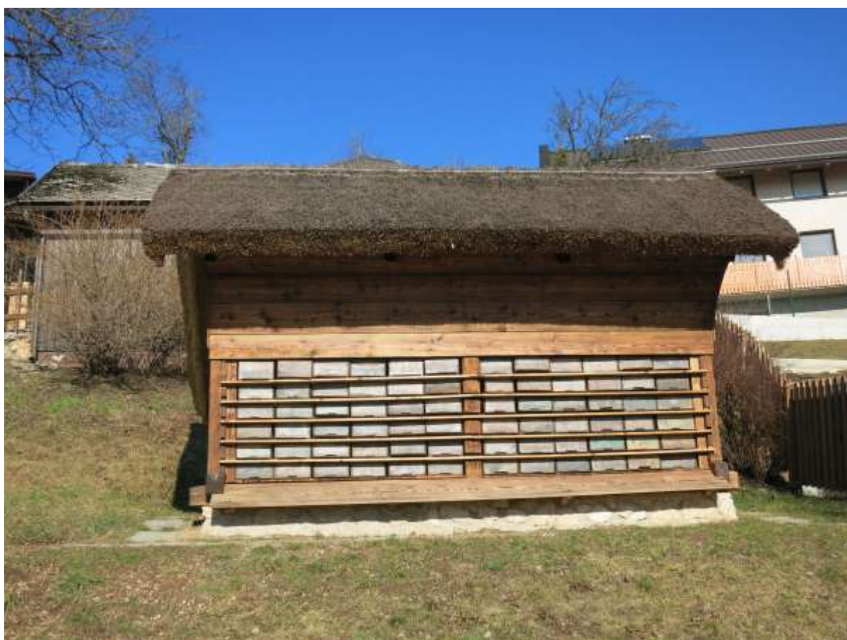
Breznica: Obnovljen Janšev čebelnjak (foto Pavla Šalehar)
