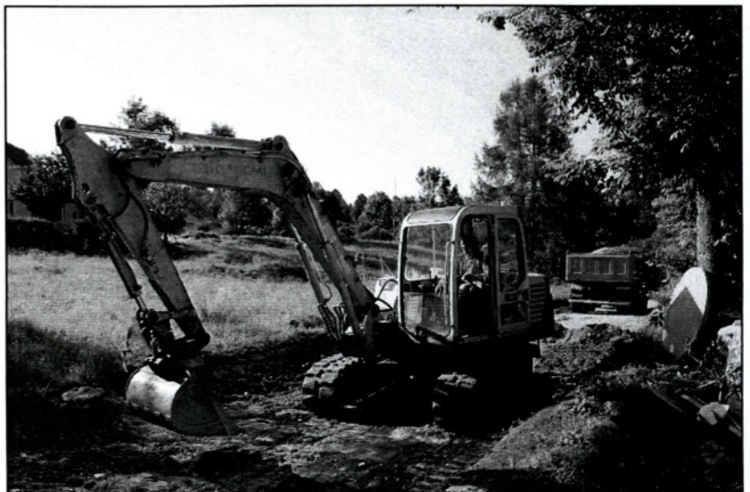
Utrjevanje novega vozišča (foto R. B.)
