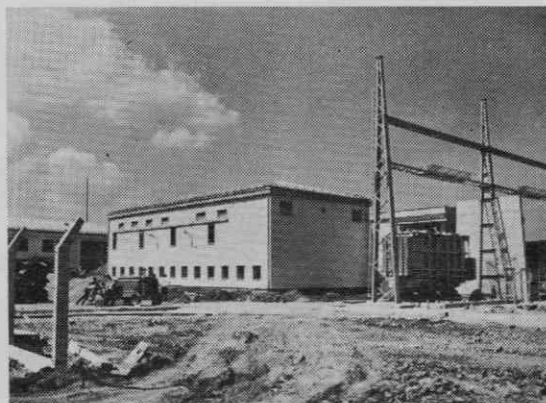
RTP Logatec. 20 KV stikališče med gradnjo
