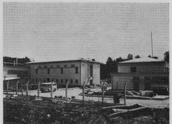
RTP Logatec. Upravna stavba in 20 KV stikališče z bočne strani
