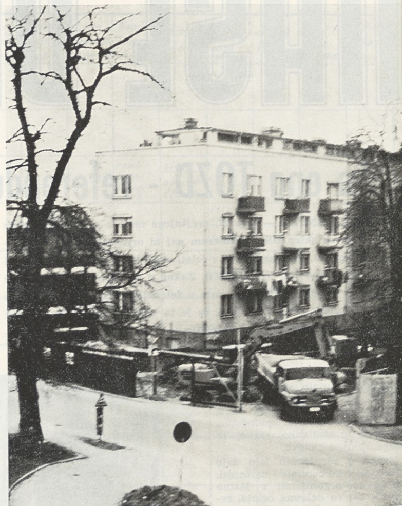
Graditev zaklonišča med trgovino tapet, banko in papirnim skladiščem
