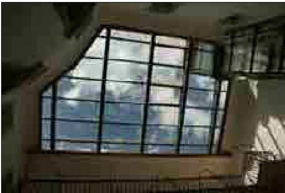
Sodobne tehnične rešitve, kot je vgradnja osebne dvigala ali zasteklitev atrija so, kot kaže primer iz Radovljice, zaradi programa in javne dostopnosti včasih nujne. Izvesti pa jih skušamo na čim manj vpadljivih delih objekta in z reverzibilnimi materiali.
