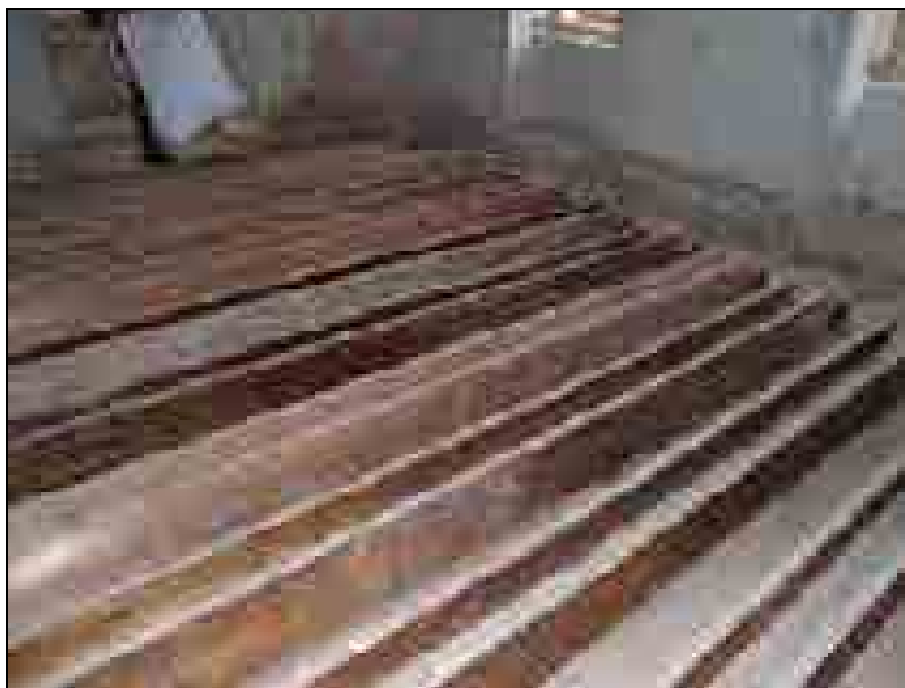
Prešibko leseno stropno konstrukcijo lahko ojačamo z dodatno plohasto obojestransko ojačitvijo.
