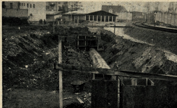
S prihodom pomladi se nadaljujejo zemeljska dela. V izgradnji je kanalizacijski vod novega prizidka plemenitilnice I
