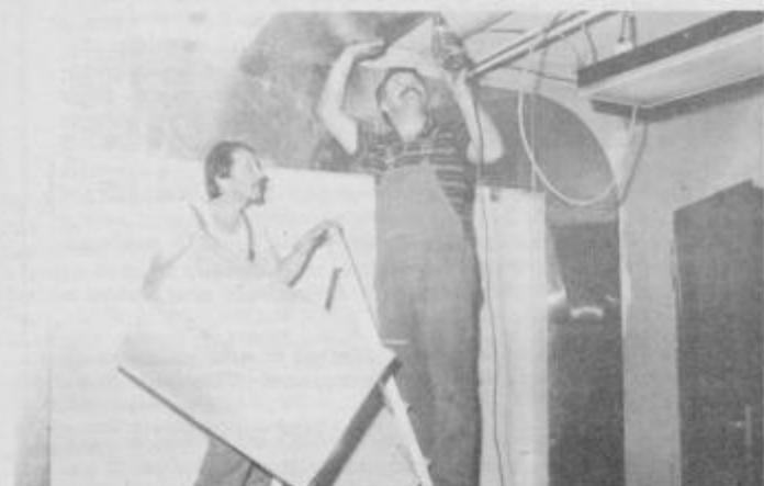
Obrtnik Milan Drevenšek in njegov pomočnik delata pri montaži prežračevalne naprave v novem radijskem studiu. (Foto: M. Ozmeč.)
