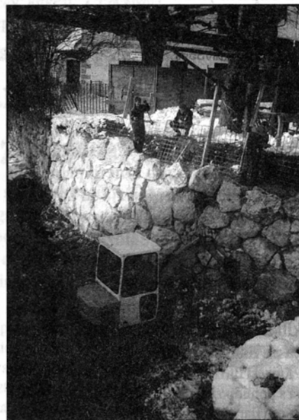
Gradbena dela potekajo kljub zimskim temperaturam
