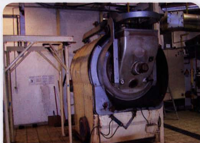
Demontaža - stari pražilnik se posavlja.
