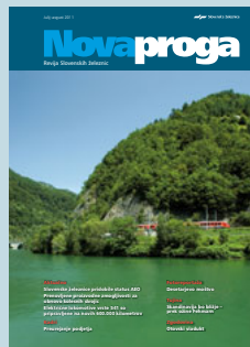
Pri Zidanem Mostu Avtor fotografije: Antonio Živkovič
