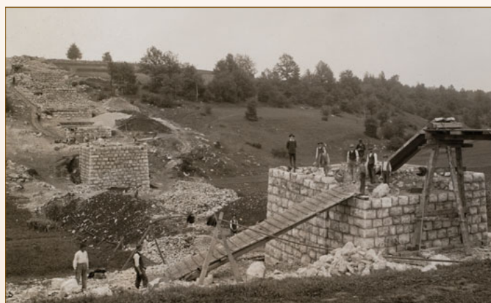
Otovski viadukt je med gradnjo v letih 1912–1914 posnel Tomaž Lauko. Fotografije so shranjene v foto albumu Gradnja belokranjske železnice v arhivu Narodnega muzeja v Ljubljani. 26. septembra 1912
