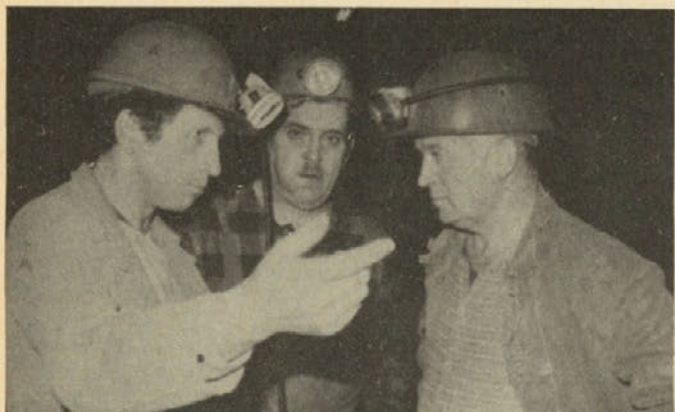
Poslovodja pri jamski mehanizaciji Ciril Čretnik, Vincenc Oblak-Zdravko in vodja rudniške strojne službe Franc Cevzar v razgovoru ob tehničnem prevzemu novega vodnega črpališča.
