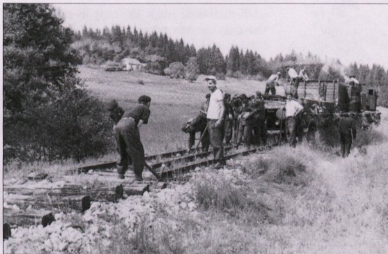
1970 - julija so začeli odstranjevati tire na železniški progi Dravograd - Velenje
