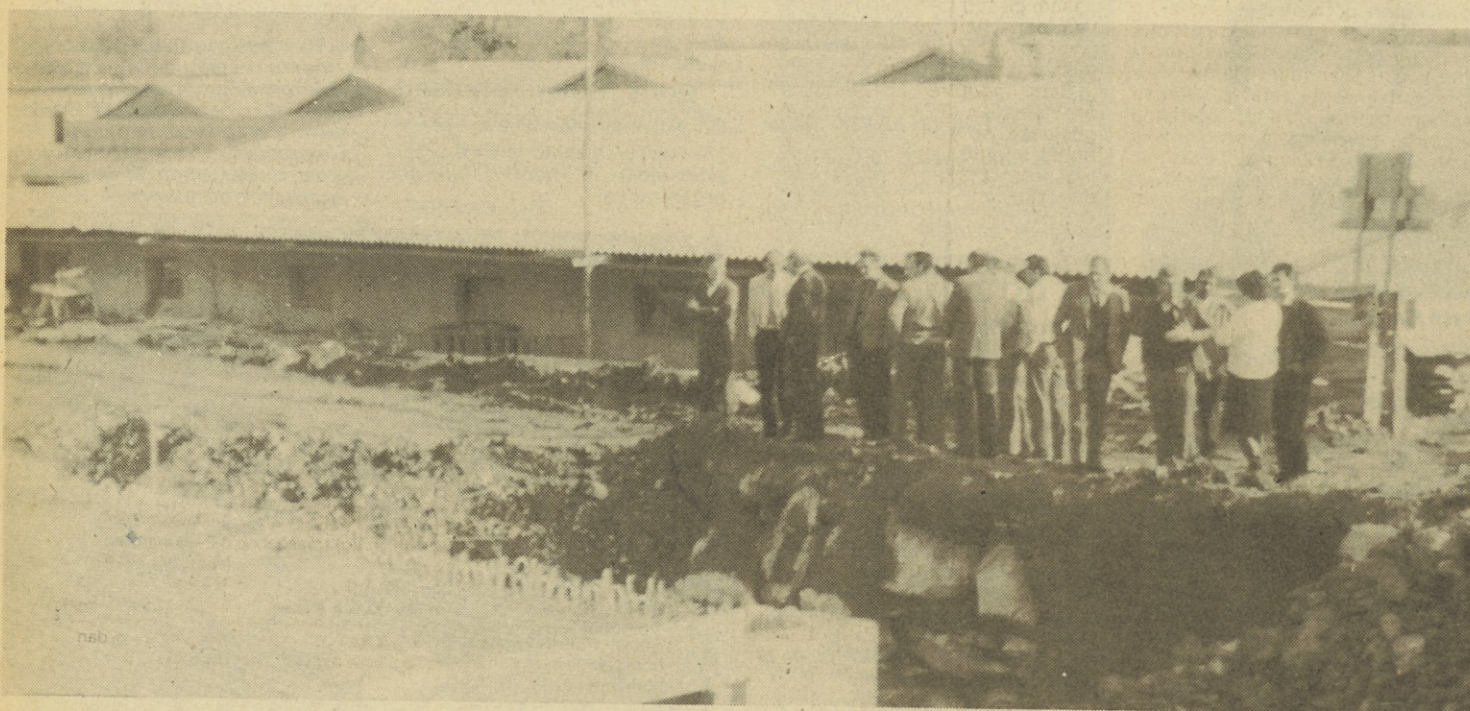
Gostje so si ogledali odlagališče PCB na tovarniškem dvorišču, katerega gradnja se bliža koncu
