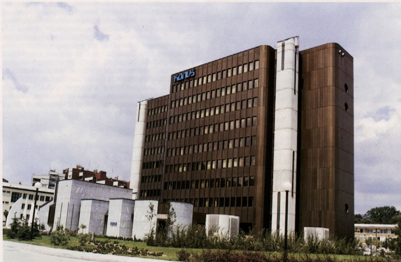
Luksuzna poslovna stavba Konus Slovenske Konjice je bila zgrajena v izredno kratkem času. Je eden izmed številnih lepih objektov, ki so ga v Slovenskih Konjicah zgradili delavci PE GO Slovenske Konjice.
