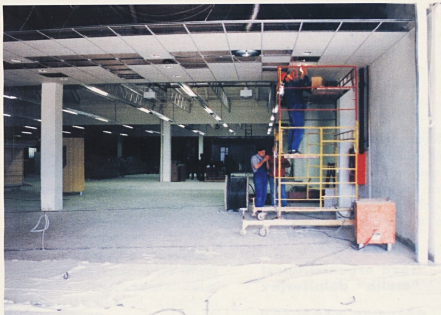
Zaključna dela v Mariboru
