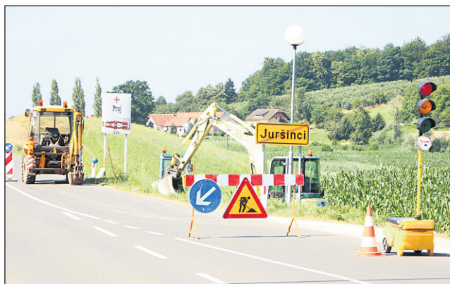
V Gabrniku so začeli urejati novo krožišče. Foto: PK
