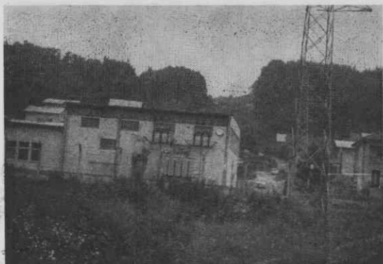
RTP (110)/35/10 kV Potoška vas v Zagorju
