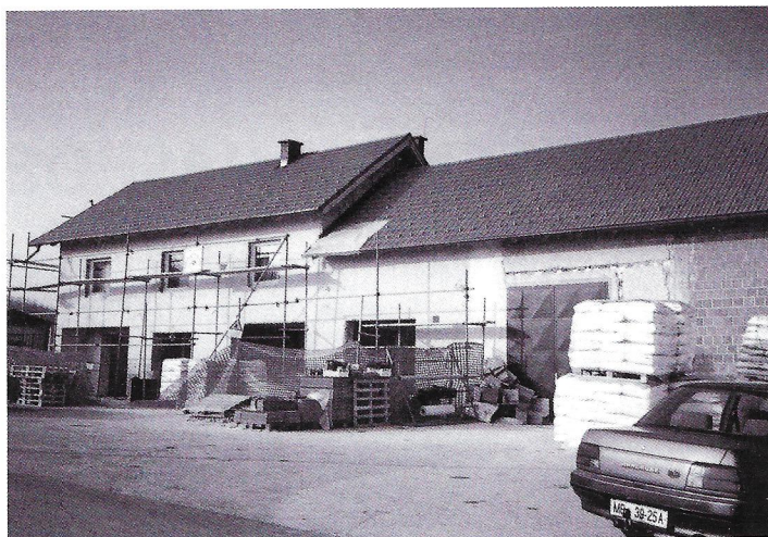
Na sliki obnovitvena dela na objektu KZ Ptuj v Drbetincih. Po mnenju ga. Dragice Herga bo imel obnovljeni objekt lepe prodajne prostore.
