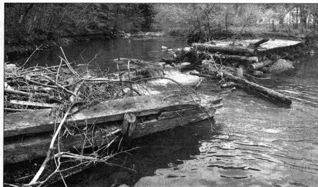
Hudourniške vode naj bi umirjali predvsem jezovi, vendar takšni, kot so na Dreči in Savinji, zagotovo ne izboljšujejo poplavne varnosti
