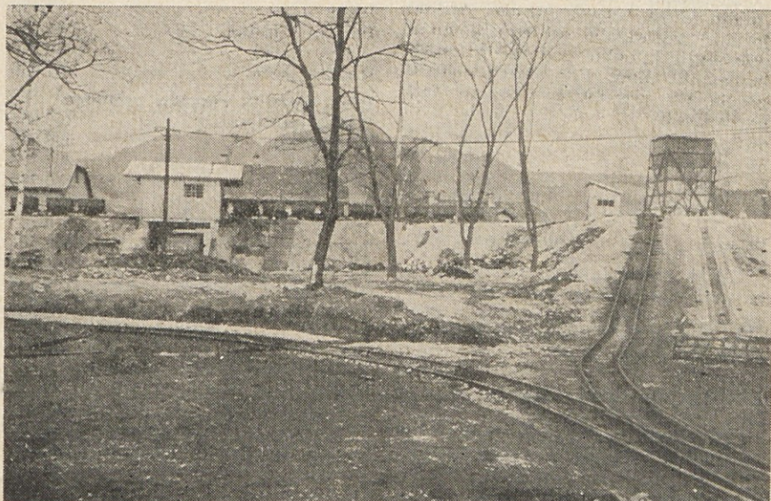
Zvrčališče za kamionski odvoz jalovine pri jašku III-Gvido, v Trbovljah (Foto: inž. Tone Bregant)
