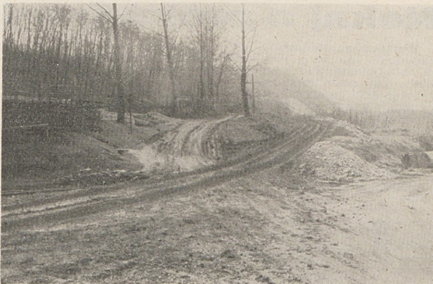
Novozgrajena cesta za odvoz jalovine iz novega zvrčalca na Gvidi do Dobrne, v Trbovljah (Foto: inž. Tone Bregant)
