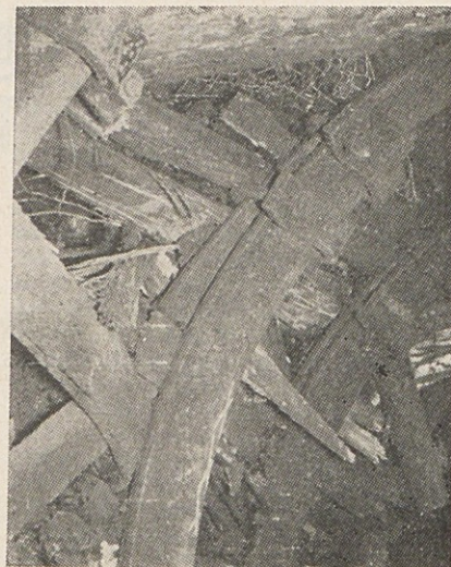
Primer nepravilno nameščenih objemk
