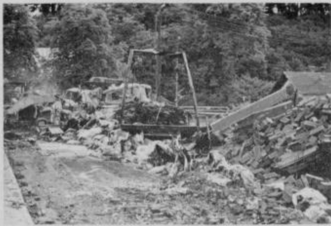
Tovornjak z opeko in nakladalec sta dala okupatorjevim tankom največ vetra.
