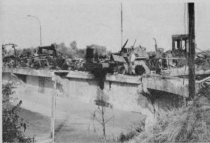
Most čez Dravo pri Ormožu po bombardiranju, ko so pogasili požar.
