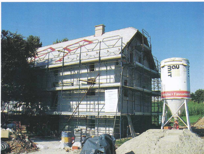
Obnova Pütarovega mlina (foto: D. Krpič)
