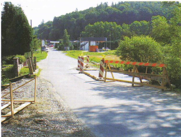
Obnova mostu in gradnja pločnika (foto: D. Krpič)
