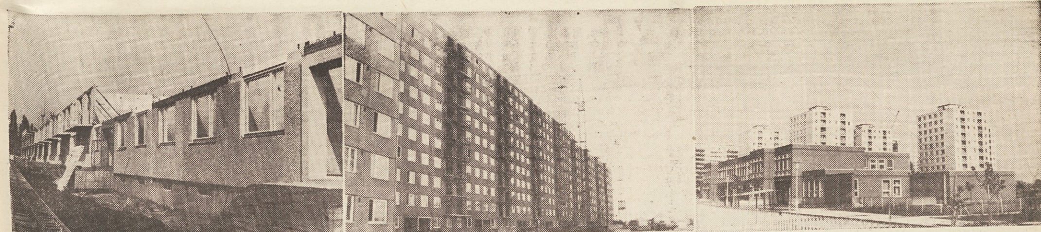
Levo: Montažna gradnja — Sredi: Gradnja montažnega bloka — Desno: Vrtec, v ozadju novi bloki
