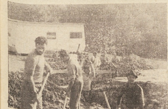
Za vodovod bo treba izkopati 2400 m jarka
